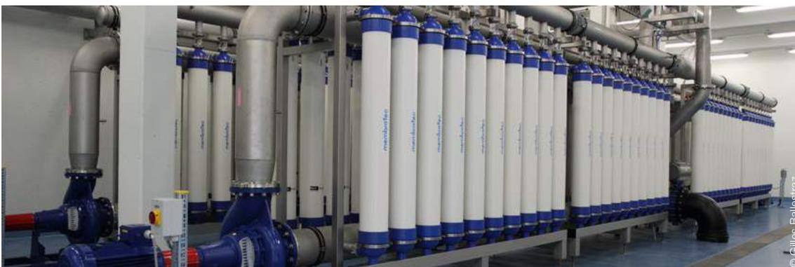
Pour les Communes de Conthey, d'Ardon et de Vétroz, Membratec a installé une usine d'ultrafiltration, d'une capacité de 500 m<sup>3</sup>/h, pour le traitement de leurs sources karstiques.
