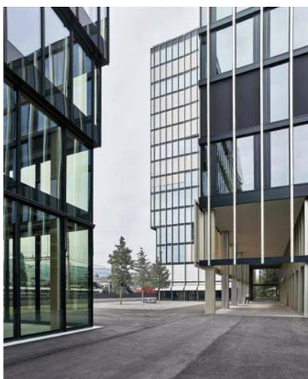
La façade en verre et métal ne révèle pas immédiatement que la tour Arbo de Suurstoffi comporte une charpente en bois. Piliers et poutres en bois lamellé-collé s'associent à des plafonds mixtes bois-béton.
